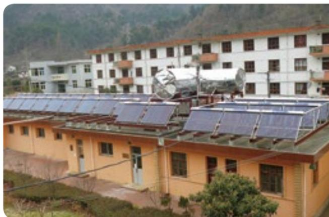
陕西太白公司对生活区浴室锅炉进行改造，新安装了33组太阳能集热管、两套空气源热泵热水机组，改变了以往传统燃煤加热洗浴用水的模式，体现了绿色清洁、节能环保的发展理念。一吨常温水利用“空气能”加热到40℃，仅需电5-7千瓦时，成本仅需几元钱，浴室每班可满足上百名员工使用。
