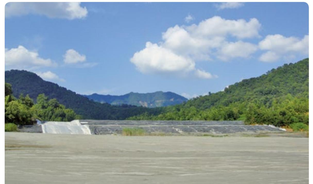
江西金山公司投入2000多万元资金，采用模袋法充填对阳山尾矿库进行扩容改造。四个分隔坝充填总量为36万方，扩容改造后的尾矿库可增加400万方库容，服务年限预计可延长8-9年。图为完工后的阳山尾矿库一、二号分隔坝体。
