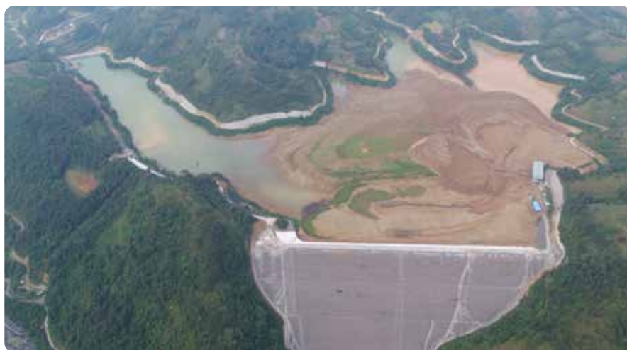
贵州锦丰公司浮选尾矿库
