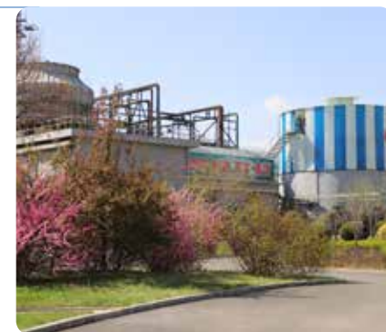
辽宁天利生物氧化项目
