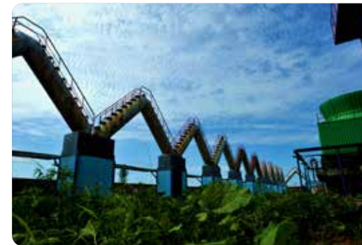
潼关冶炼公司废渣综合回收系统
