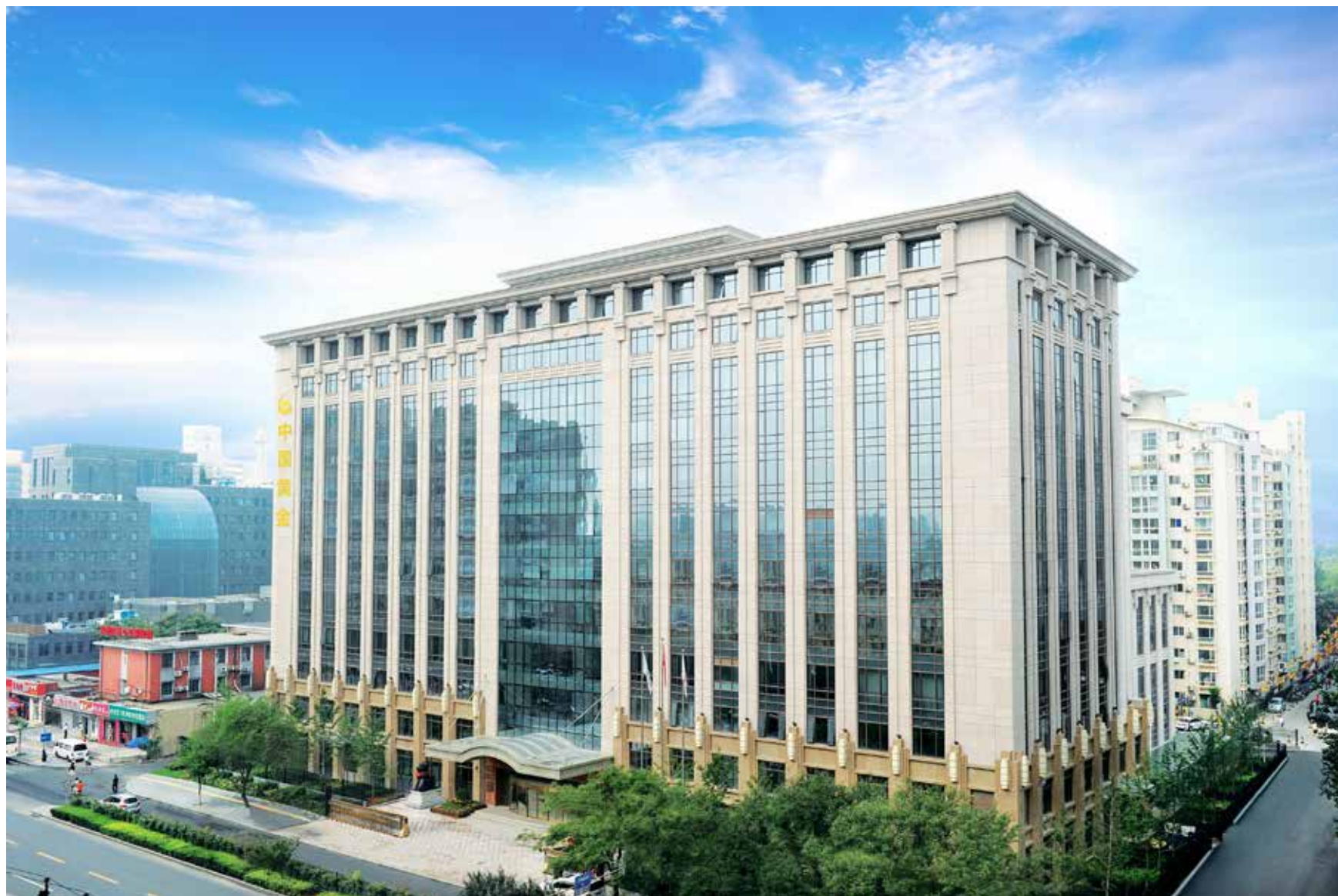
中国黄金总部大楼
